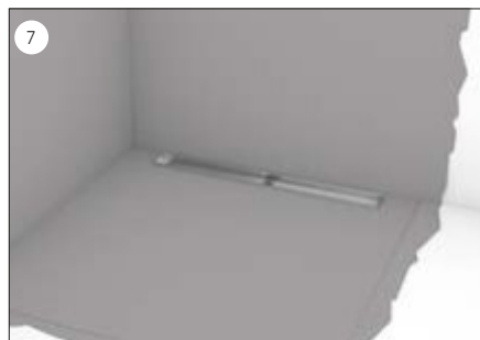
Nach dem vollständigen Aufbringen der Verbundabdichtung...
